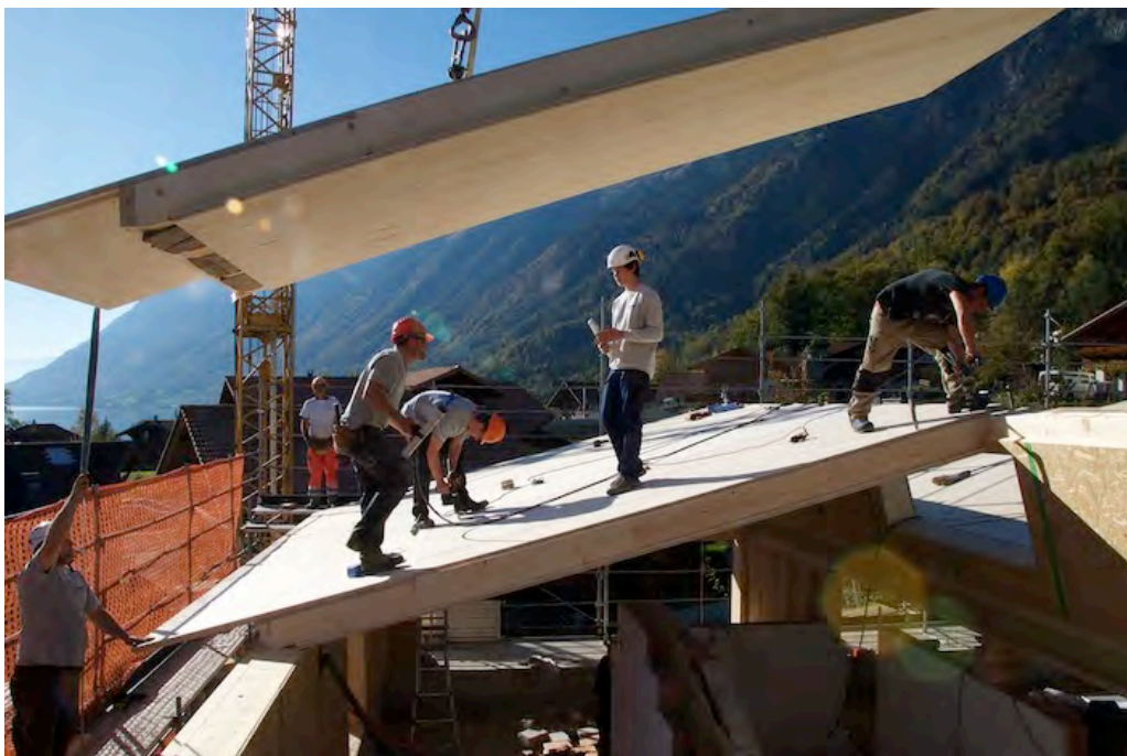
Dachelemente werden mit dem Kran herbeigeführt.
