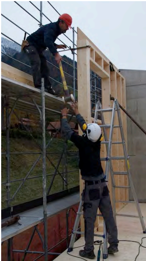
Der Projektleiter Holzbau stellt gemeinsam mit dem Lernenden das Holzelement für das künftige Holzlager.
