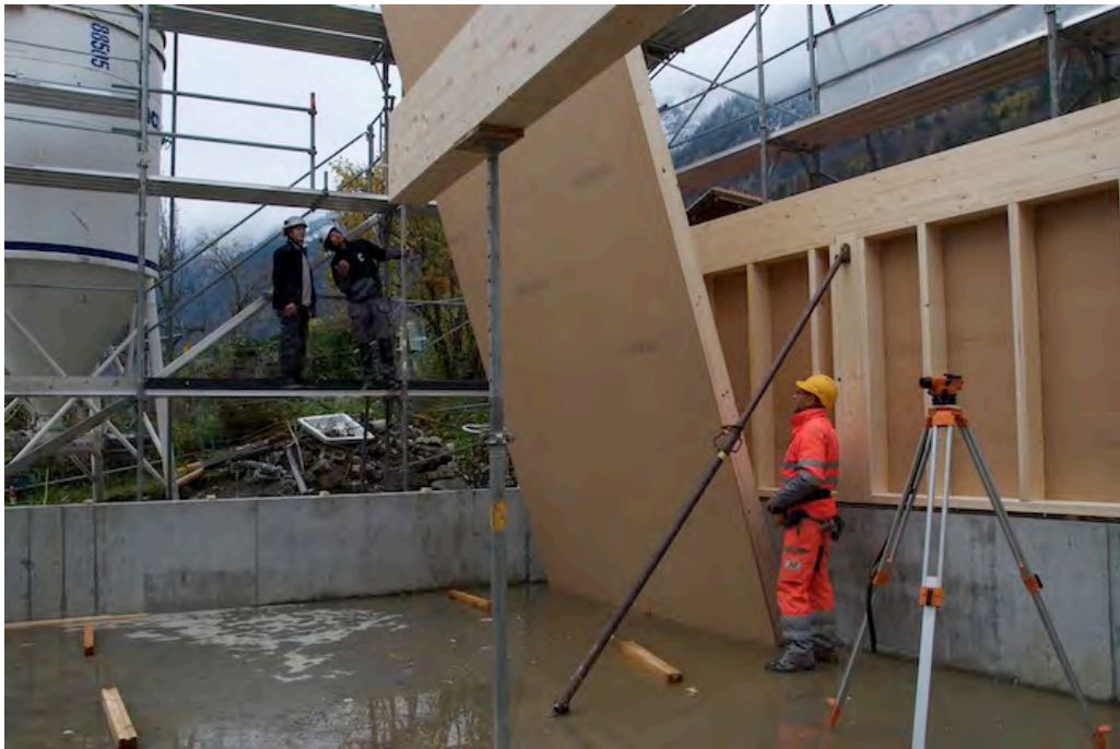
Der Kranführer positioniert gemeinsam mit zwei Zimmermann-Lernenden ein Wandelement des zukünftigen Holzlagers.
