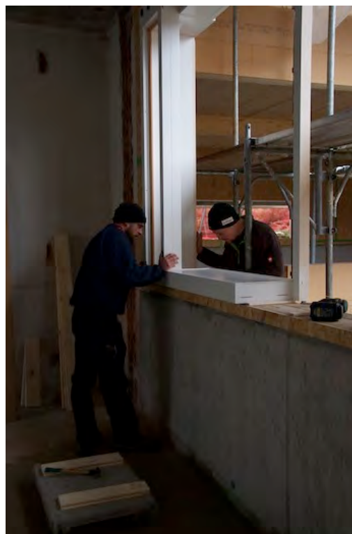
Die Fensterrahmen werden eingepasst.
