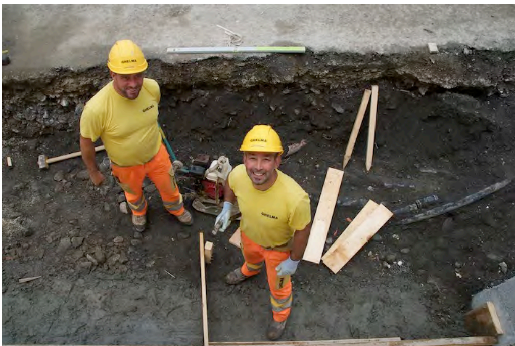
Zwei Fachkräfte erstellen eine Schalung für ein Fundament.
